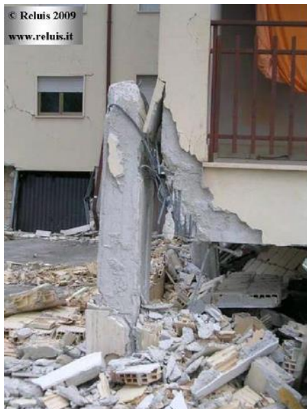
Figura 4.3 Meccanismi di collasso di colonne per edifici in c.a. colpiti dal terremoto dell'Aquila, (fonte Reluis 2009) [32]
