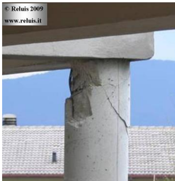
Figura 4.3 Meccanismi di collasso di colonne per edifici in c.a. colpiti dal terremoto dell'Aquila, (fonte Reluis 2009) [32]
