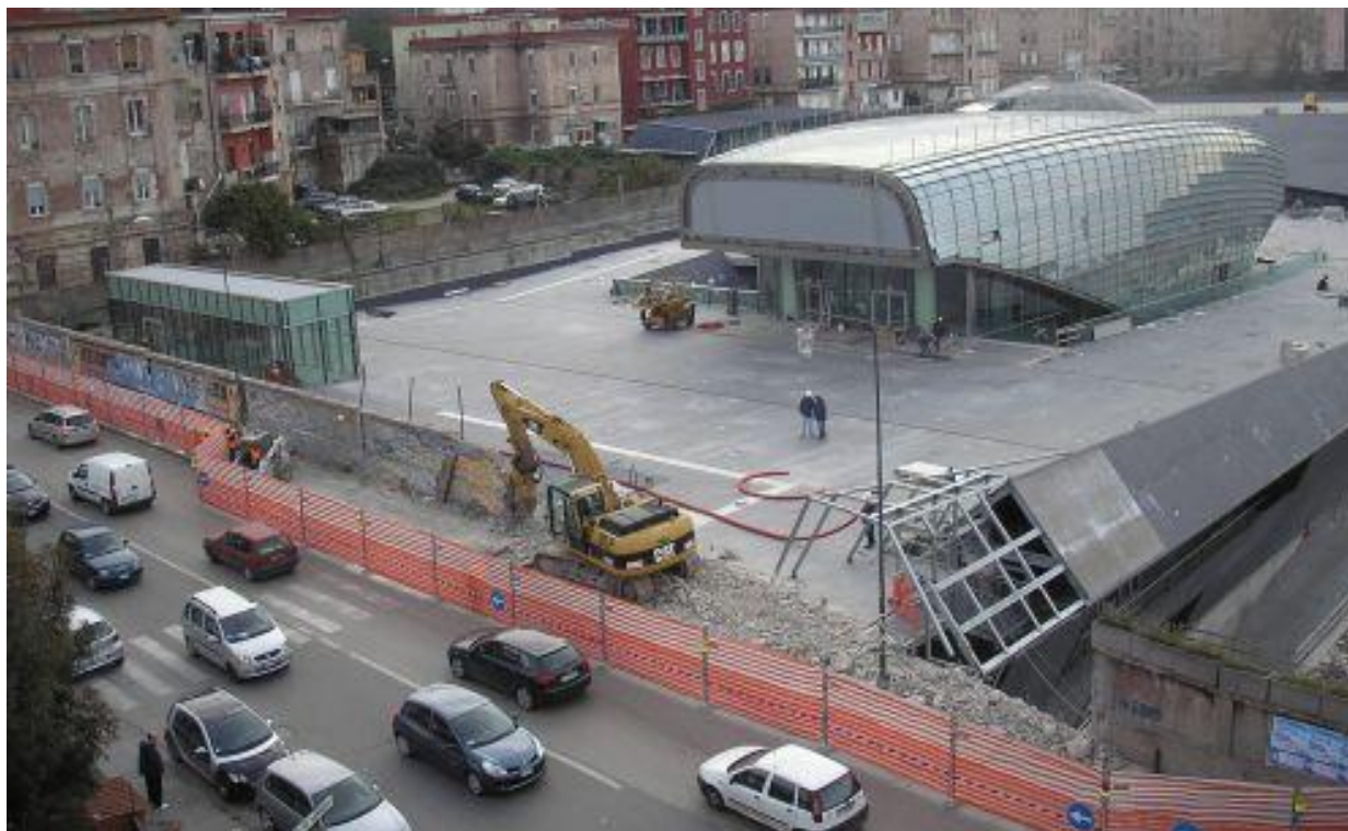
2010 abbattimento del muro innanzi alla porta del parco
