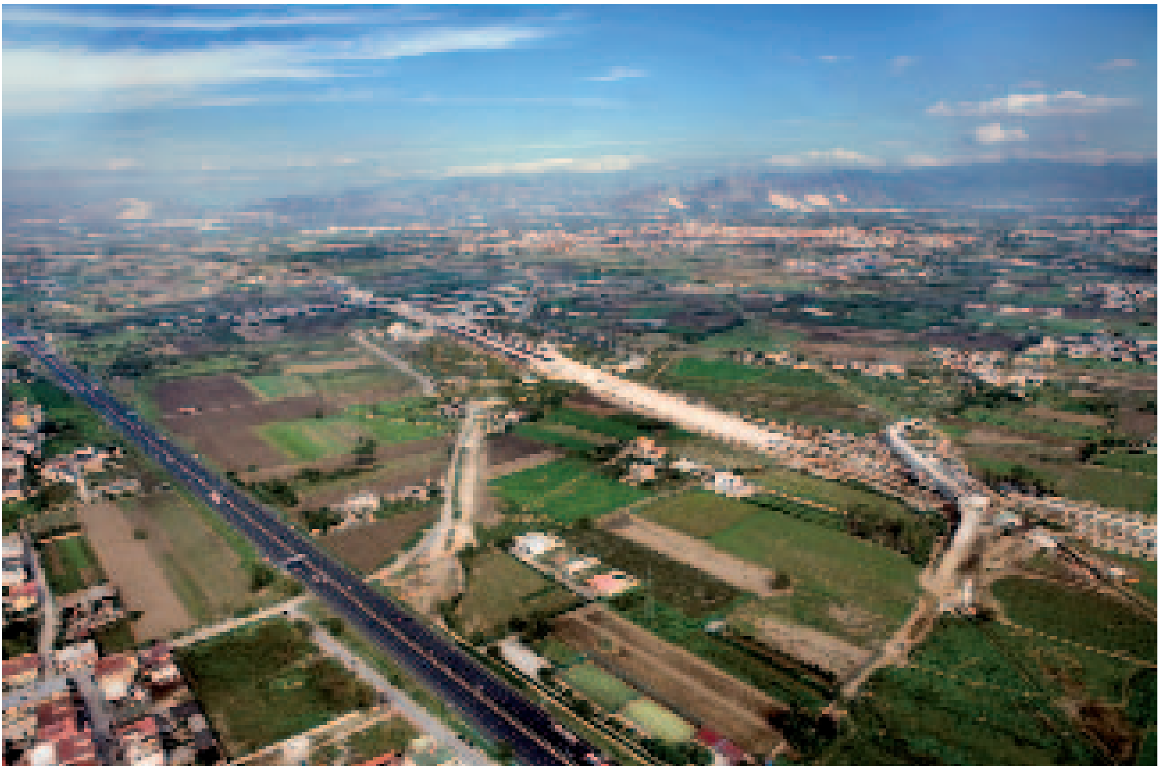
Afragola. Il cantiere della stazione dell'Alta Velocità
