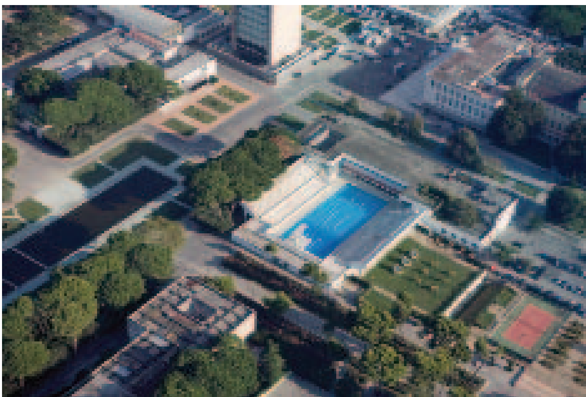
Napoli, Mostra d'Oltremare, l'Arena Flegrea e, in basso, l'area degli impianti sportivi dopo il recente restauro
