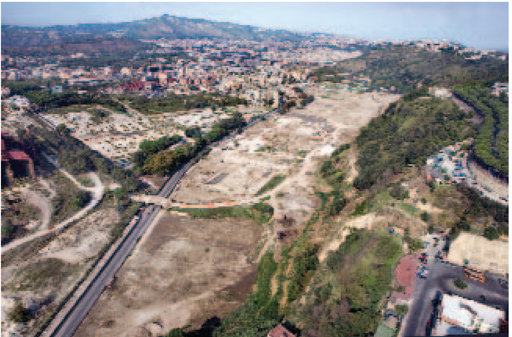
Napoli. Bagnoli, l'area interessata dai lavori per la realizzazione del Parco dello Sport
