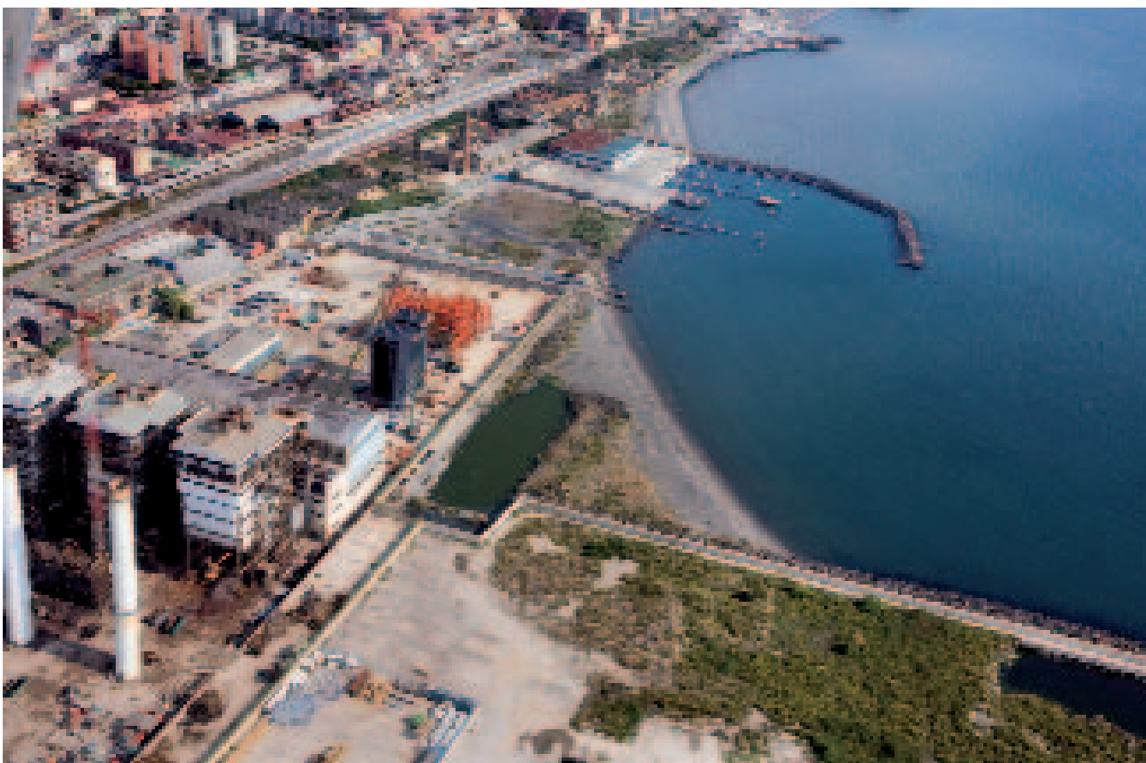
Napoli. L'area del nuovo porto turistico di Vigliena e i lavori di trasformazione della Centrale ENEL
