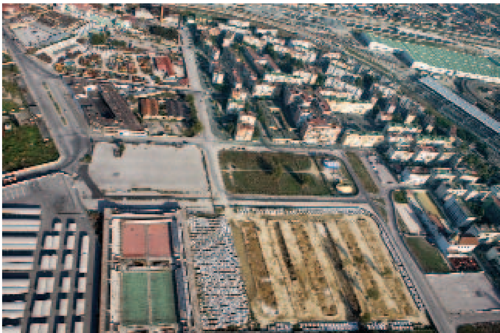
Napoli, completamento del Centro Direzionale
