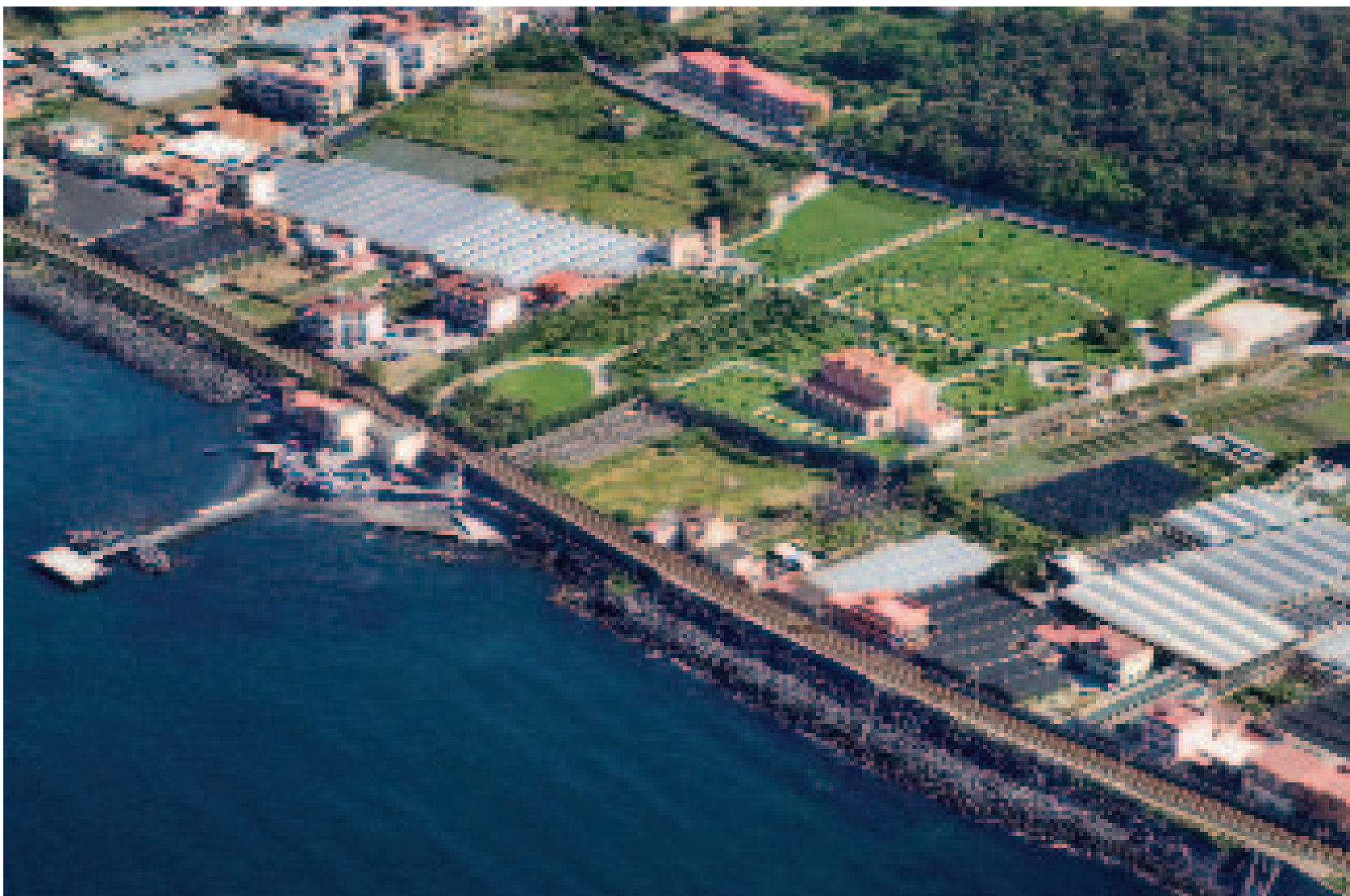
Ercolano. Il restauro del parco della Favorita e la fermata del Metrò del Mare
