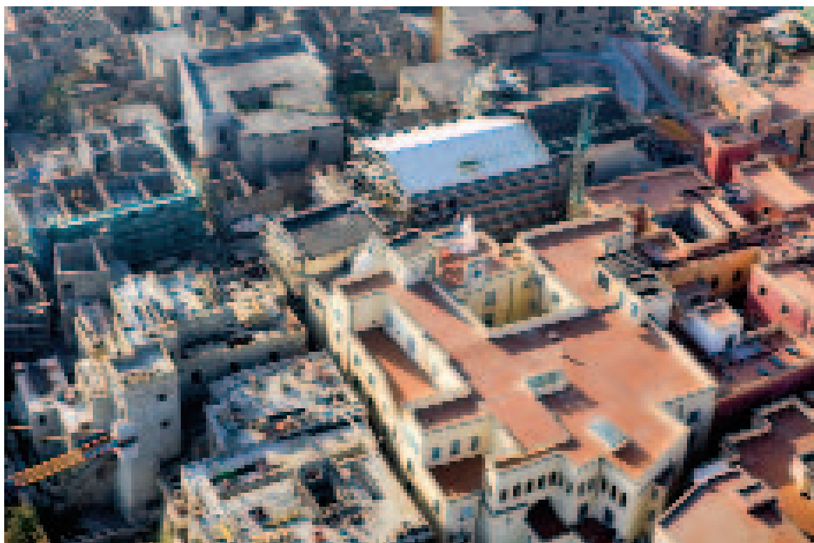
Pozzuoli. Il recupero del Rione Terra. In basso, il cantiere di restauro del Duomo
