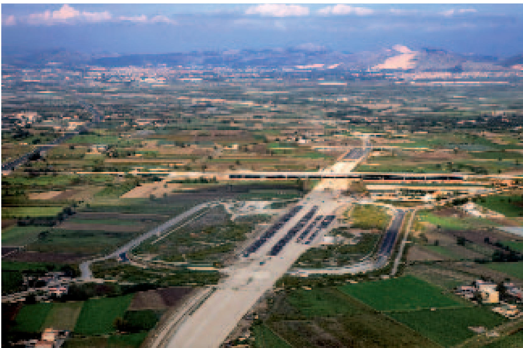
Afragola, il cantiere della stazione dell'Alta Velocità
