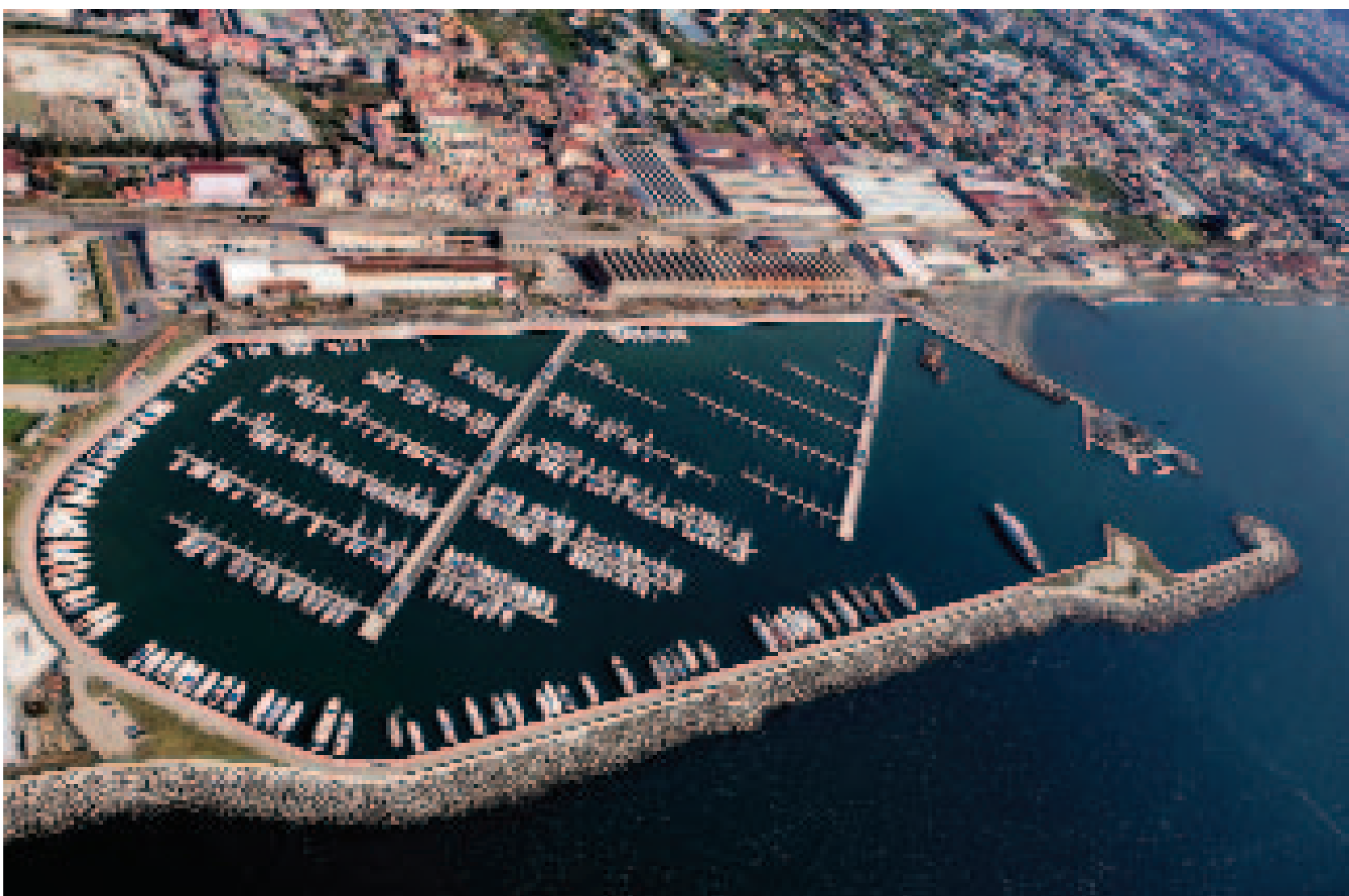
Castellammare di Stabia. Il nuovo porto turistico Marina di Stabia
