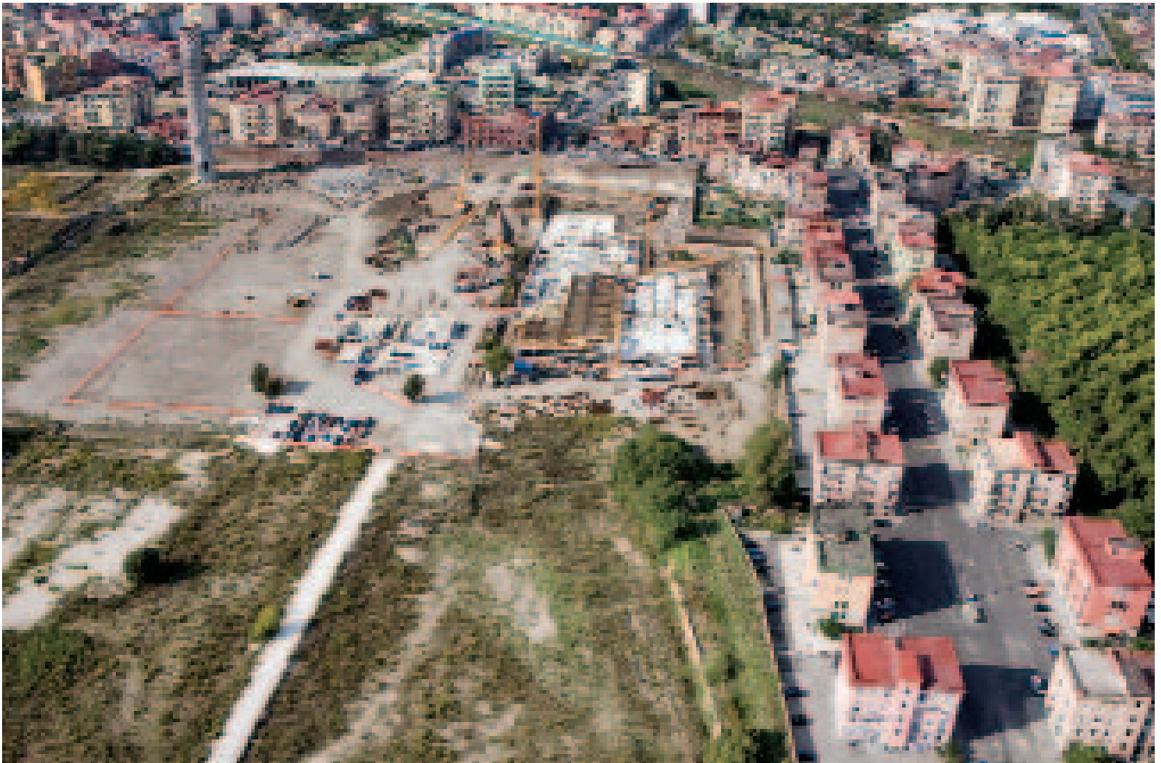
Napoli. Il cantiere della «Porta del Parco» a Bagnoli
