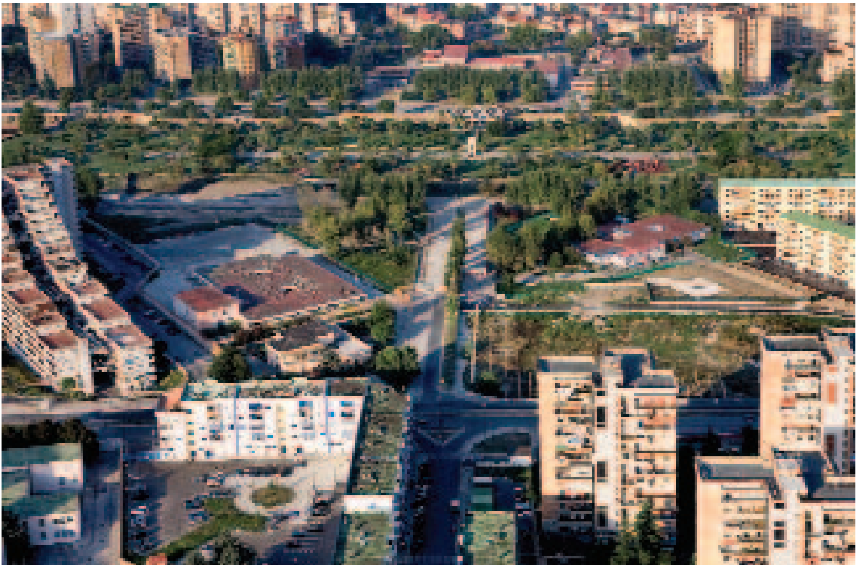
Napoli. Area per la realizzazione della piazza della Socialità a Scampia
