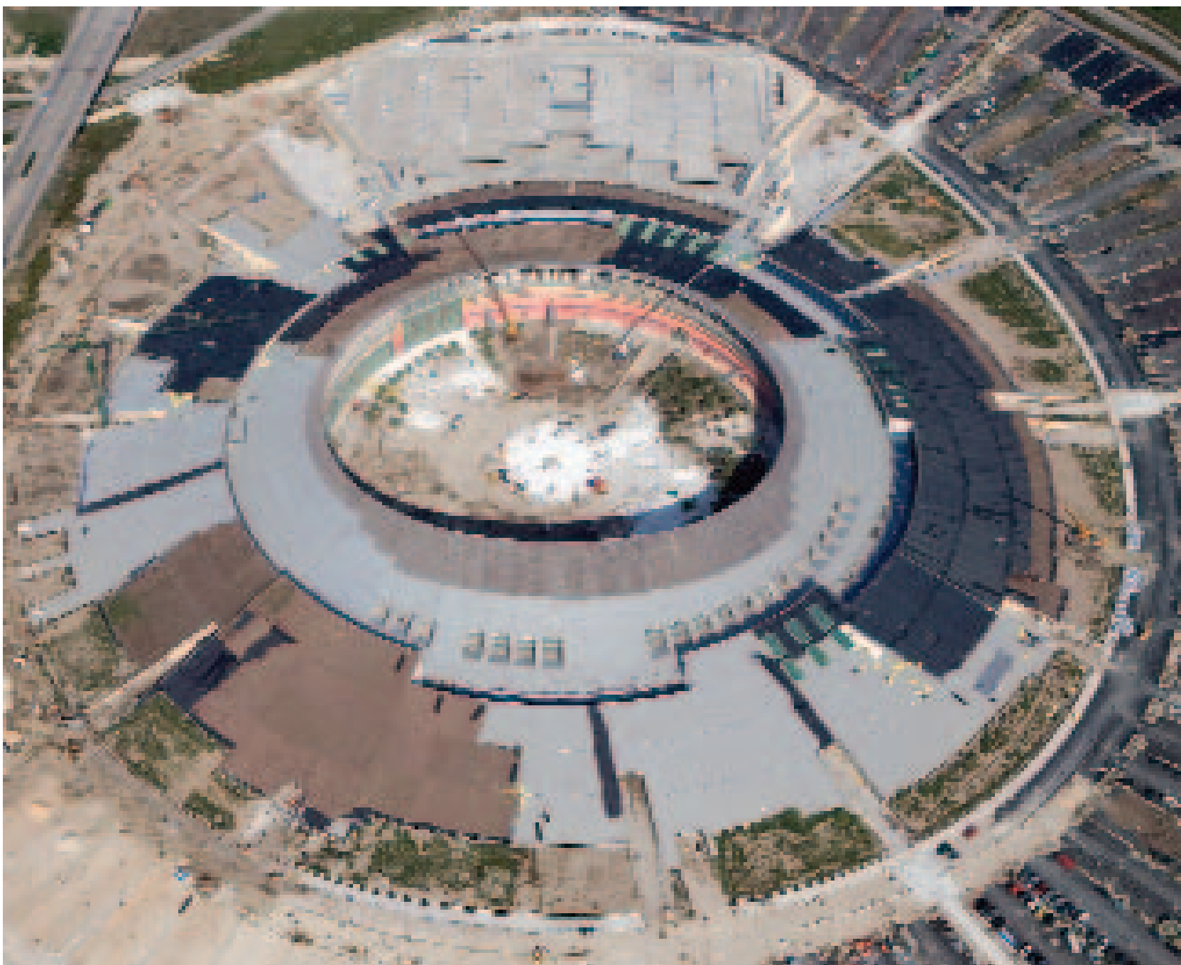
Nola. Il cantiere del centro servizi Vulcano Buono
