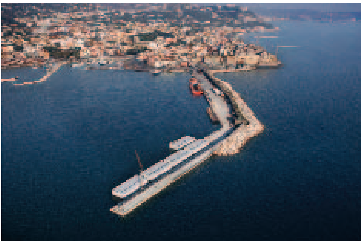
Pozzuoli. Lavori per il prolungamento del molo Caligoliano
