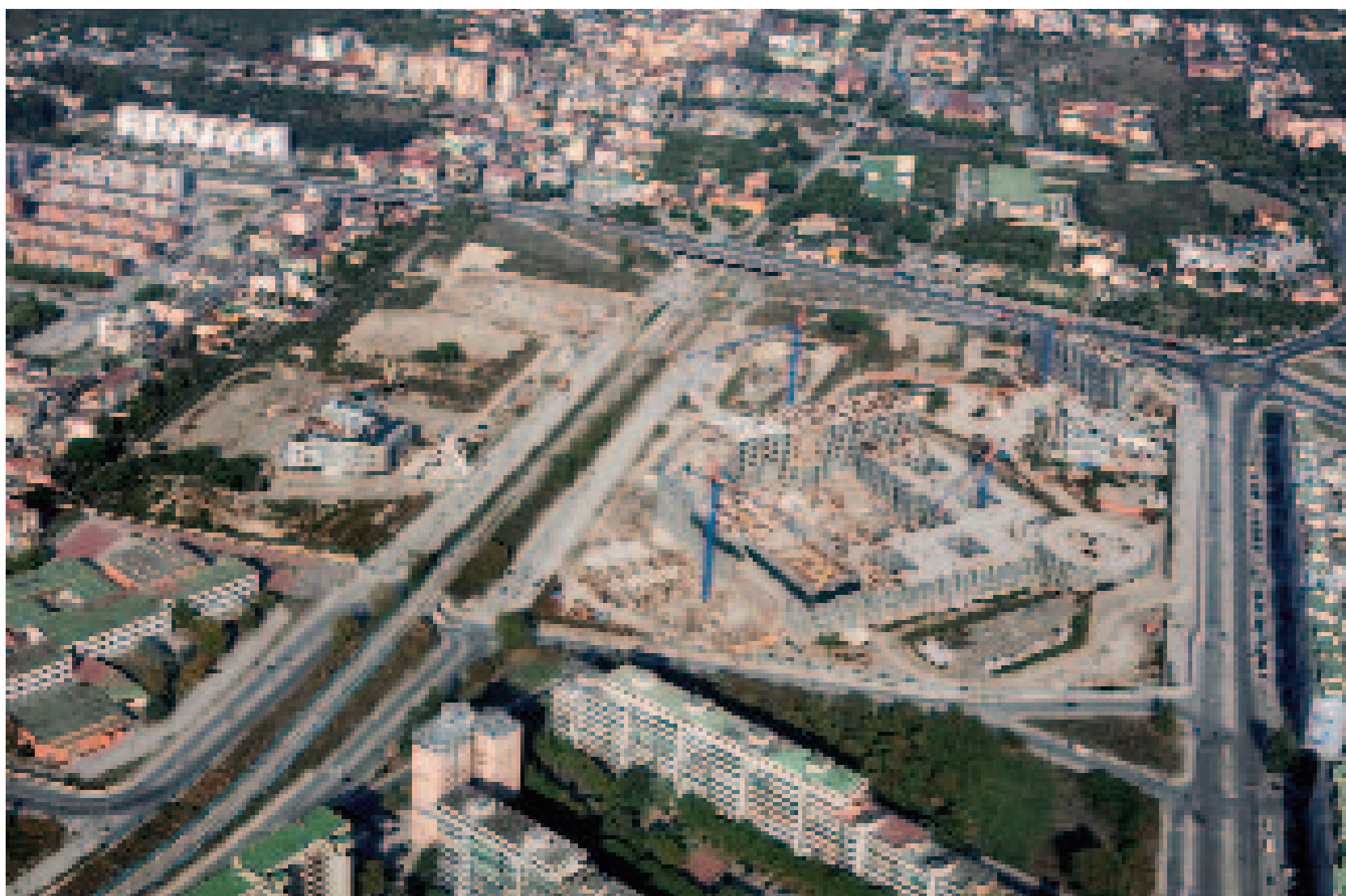
Napoli, la realizzazione dell'Ospedale del Mare
