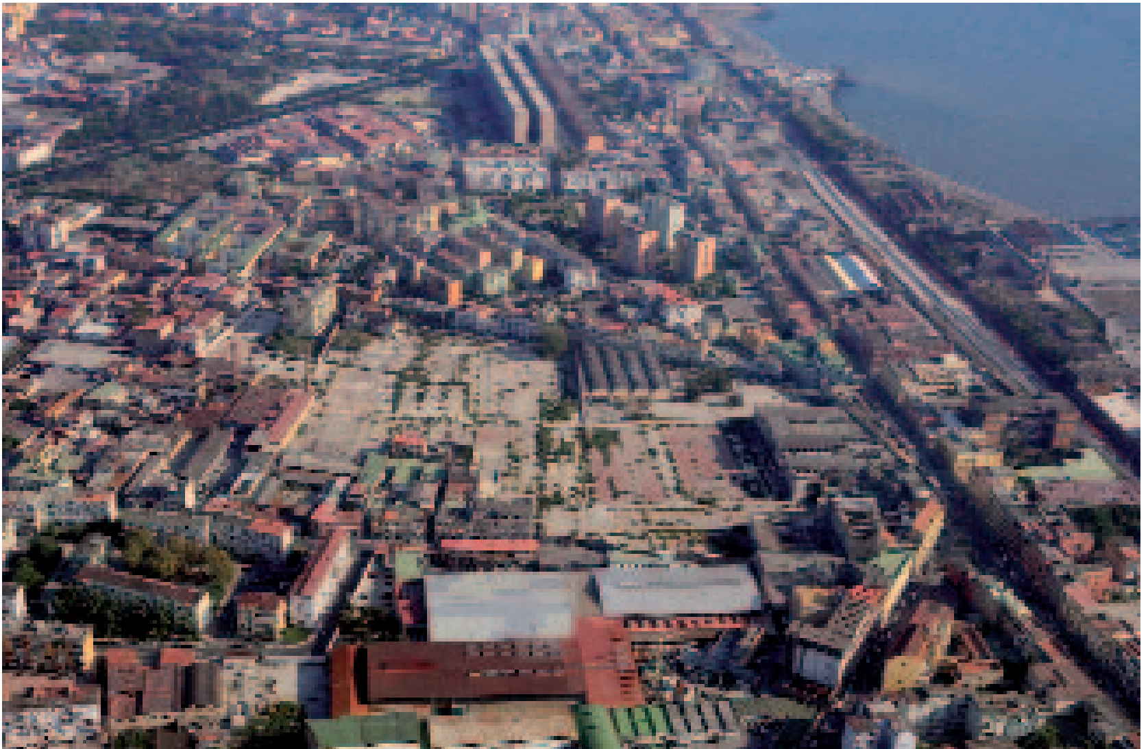
Napoli, l'area dell'ex stabilimento Cirio a San Giovanni, per l'insediamento delle nuove facoltà di Giurisprudenza e Ingegneria
