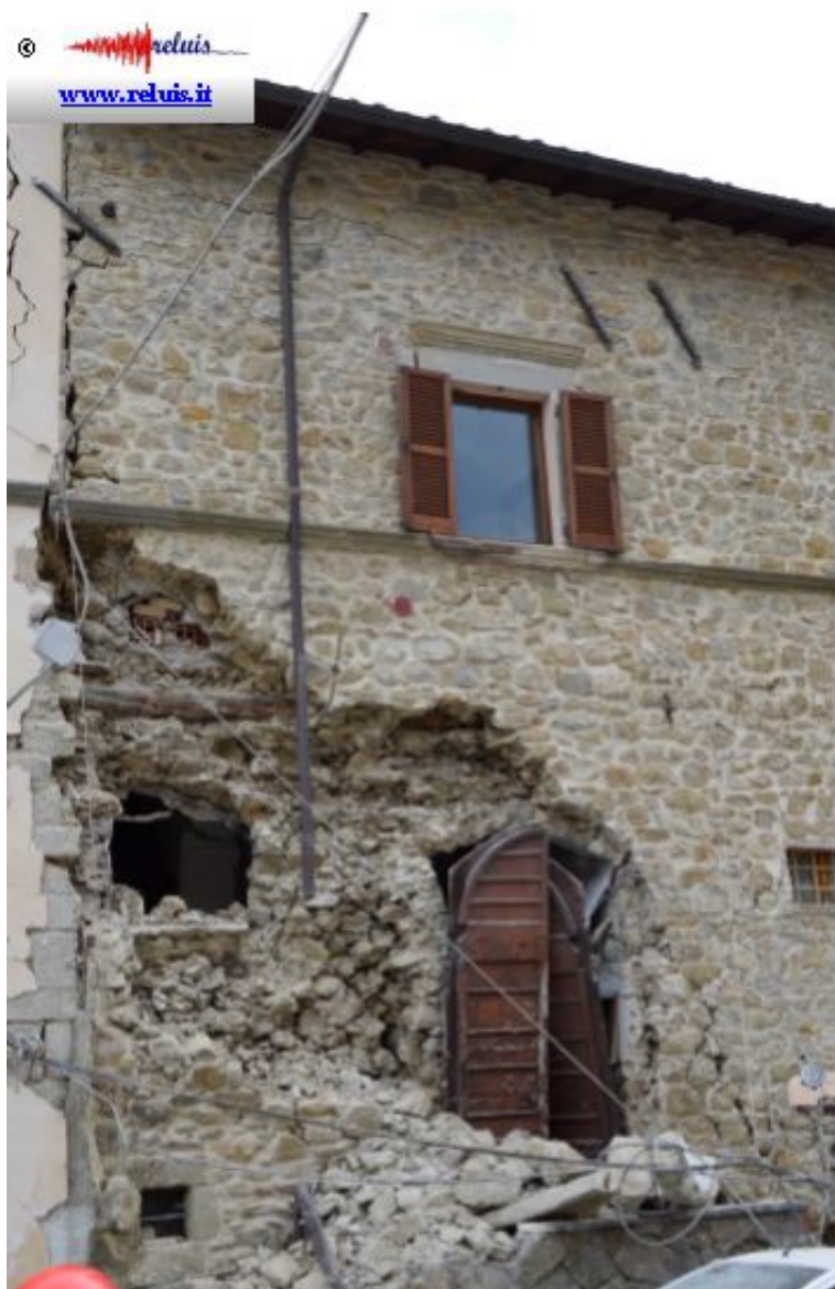
Edificio in muratura – Arquata del Tronto Si disgregazione del paramento esterno della muratura. Notare la presenza delle catene, probabilmente evitate i meccanismi fuoripiano
