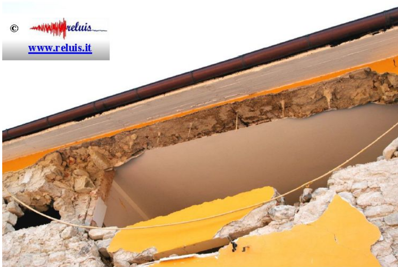
Edificio in muratura - Accumoli
