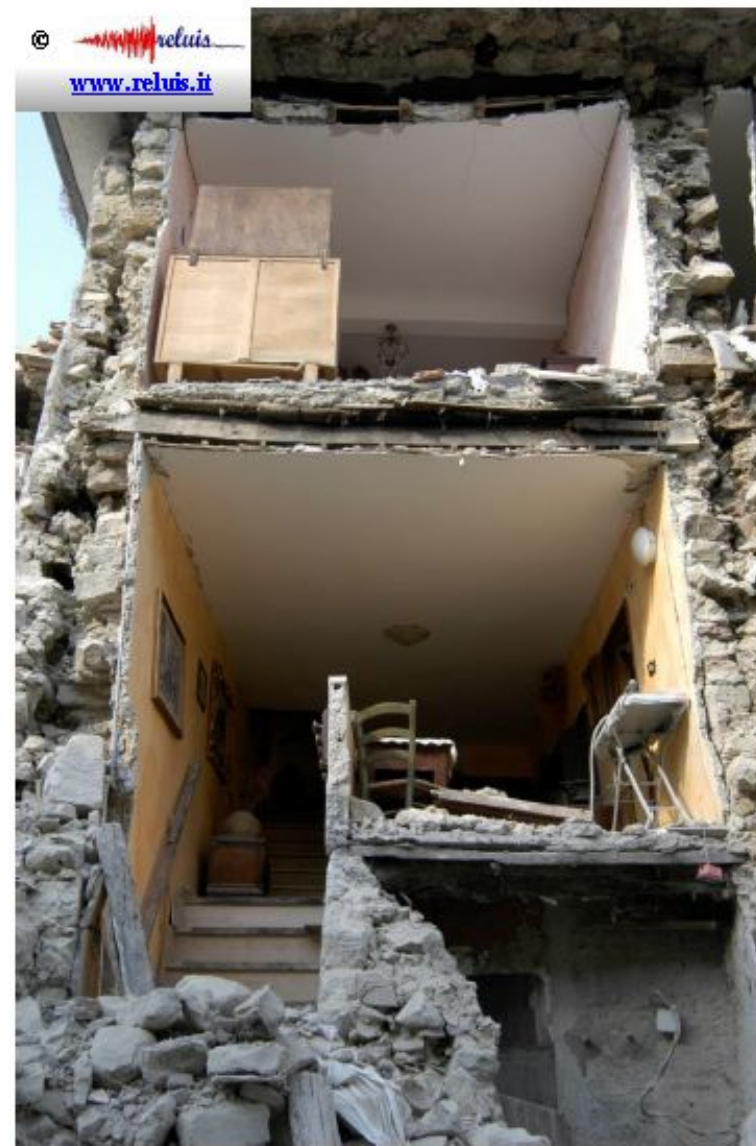
Edificio in muratura - Amatrice La parete muraria è messa in luce della sezione trasversale della muratura (doppio para scassamente ammorzati trasversalmente).
